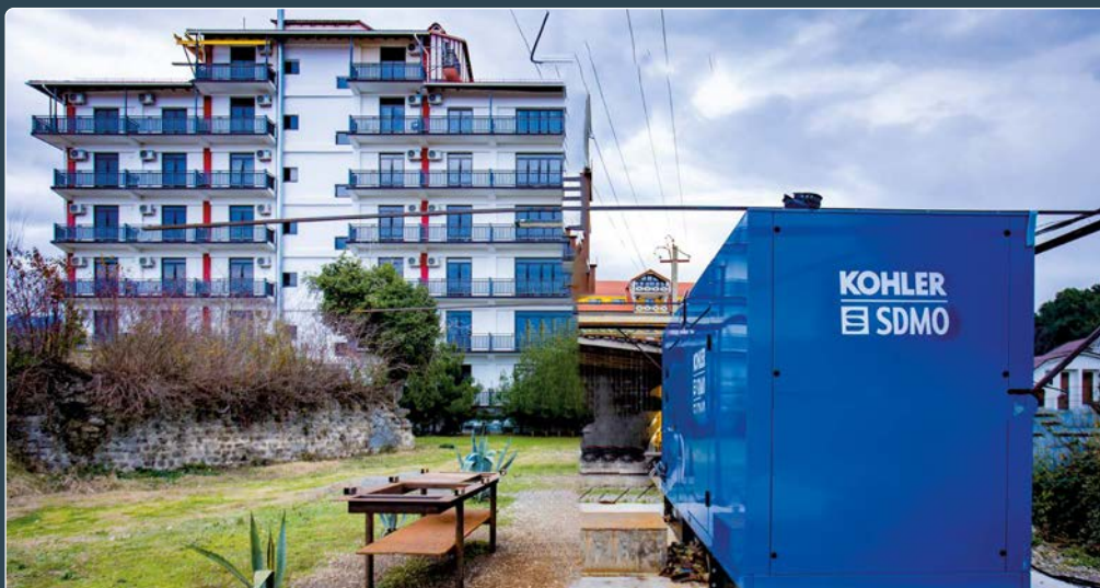
⚡ 320 кВт SDMO 320 кВт кожухе для отеля Апсара в Абхазии
