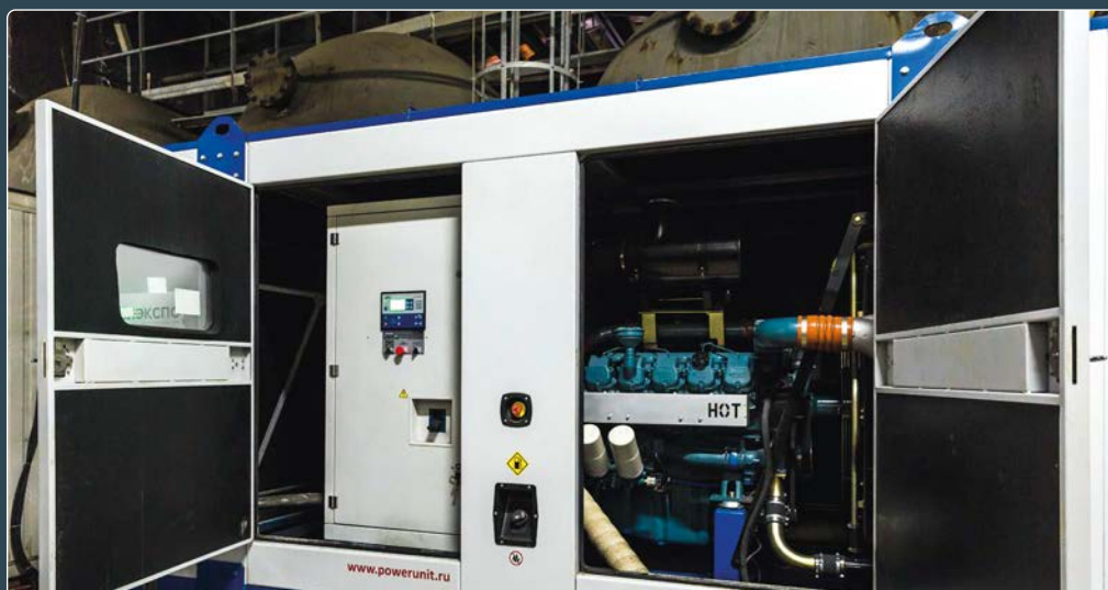
⚡ 400 кВт 400 кВт на двигателе Doosan для бетонного завода
