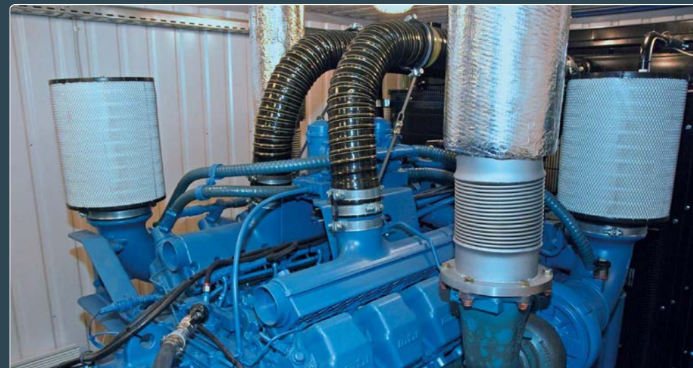
⚡ 840 кВт ДЭС MTU 640 кВт и Iveco 200 кВт для птицефабрики
